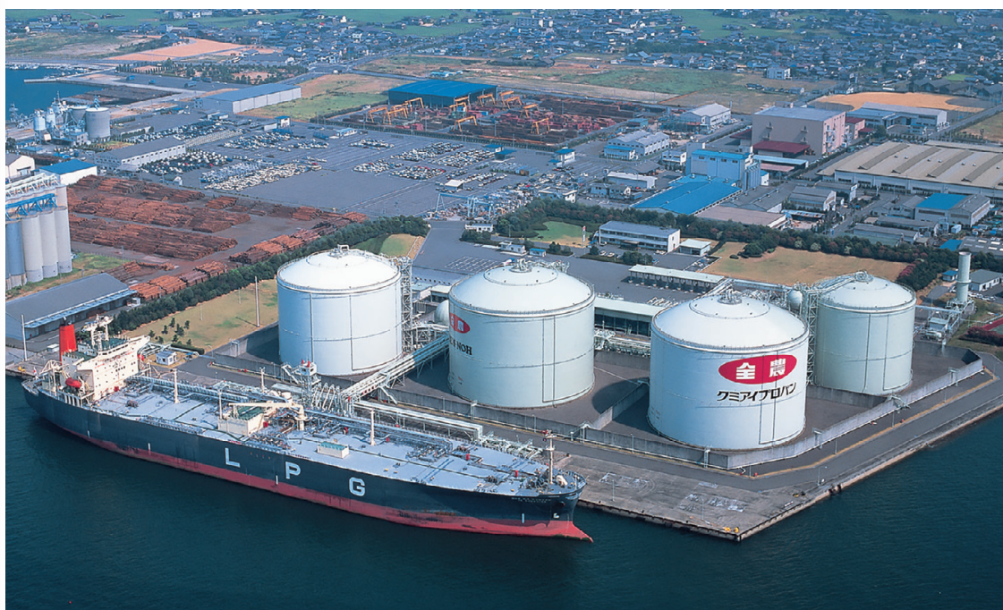
坂出LPガス輸入基地
