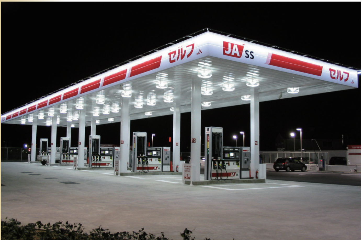
LEDを使用した照明
