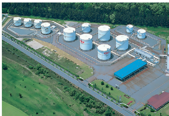
新潟石油基地
